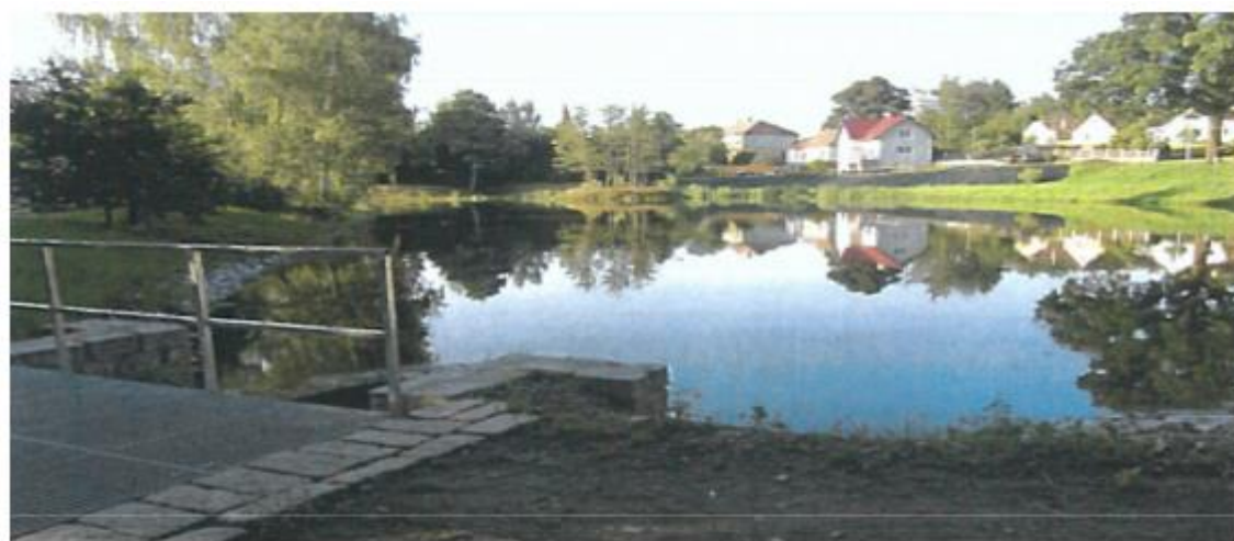
Obr. Stav po realizaci
